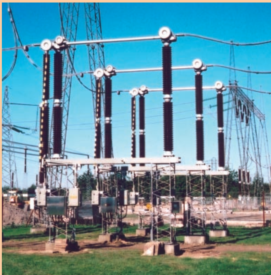
Разъединитель вертикально - поворотного типа в ячейке воздушной линии
