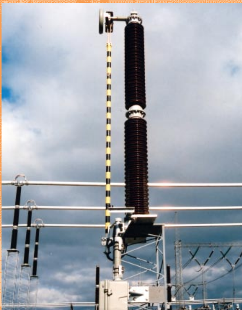
Отдельно стоящий заземлитель
