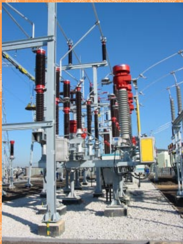
Компактное устройство типа „Simobreaker compact“
