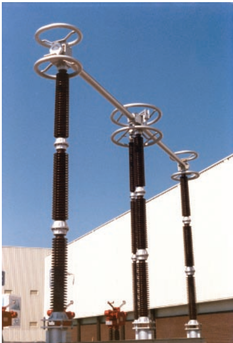
Разъединитель горизонтально - поворотного типа с двумя разрывами
