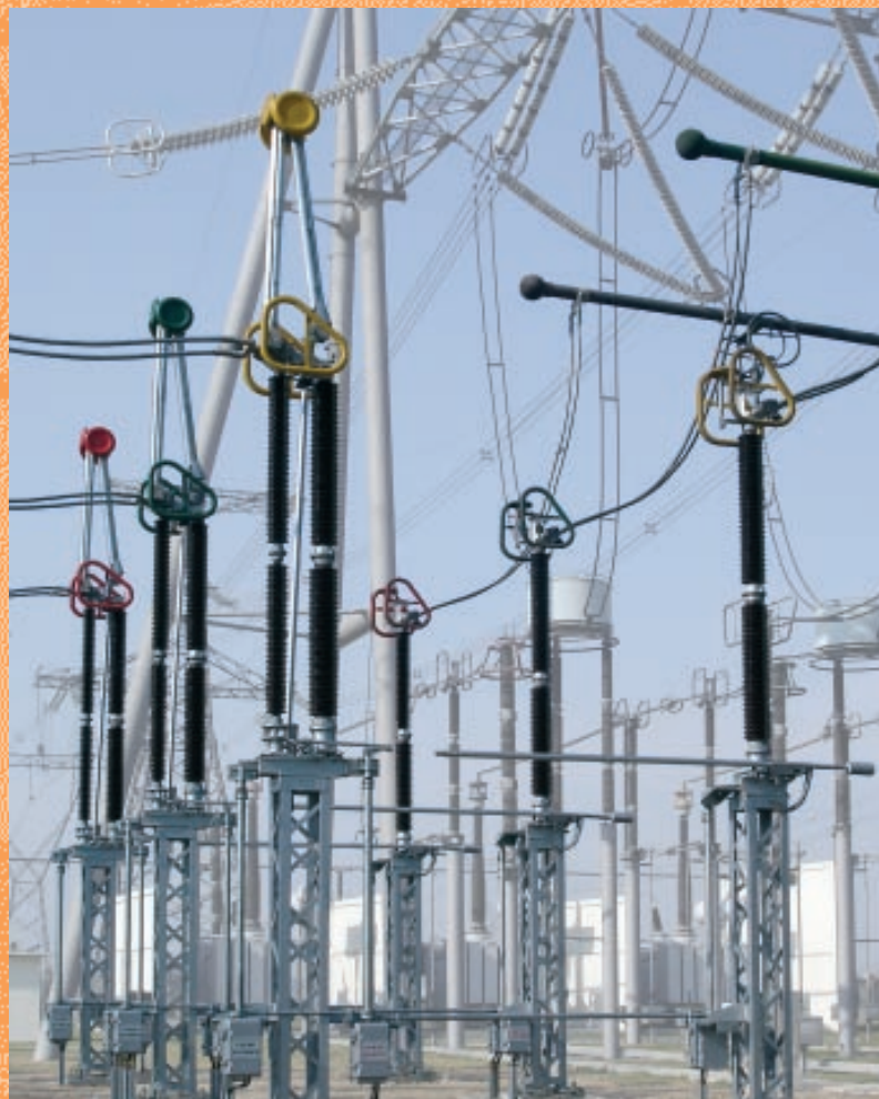
Разъединитель горизонтального - полупантографного типа
