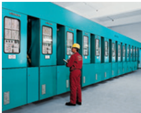
Ячейка с интегрированным шкафом местного управления
