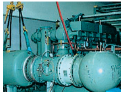
Высоковольтные испытания на месте установки
