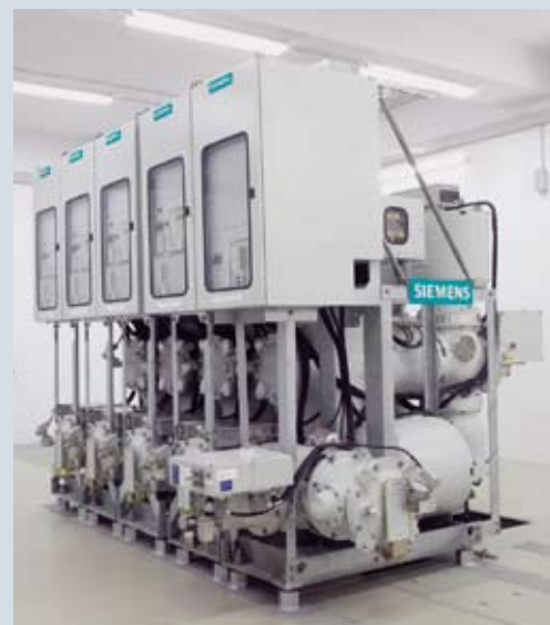
КРУЭ 8DN8 на напряжение 72,5 кВ, компоновка с одинарной сборной шиной
