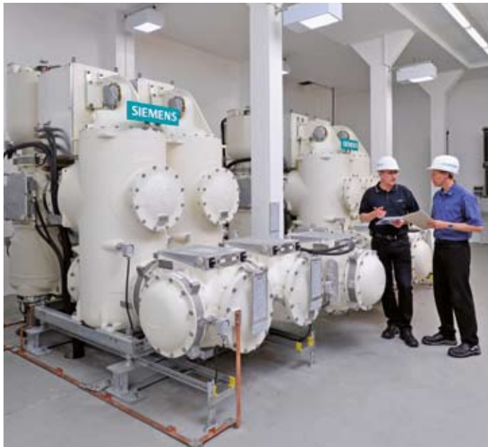
Модули типоряда 8DN8 обеспечивают максимальную степень гибкости размещения КРУЭ
