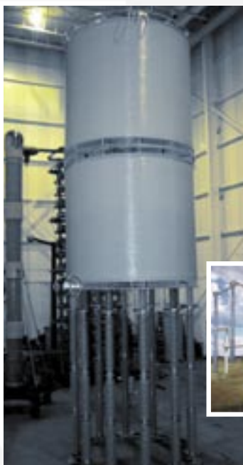
Реактор последовательного включения и шинное подключение сглаживающих конденсаторов
