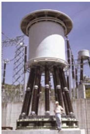
Сейсмостойкий сглаживающий реактор на напряжение 500 кВ
