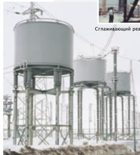
Сглаживающий реактор на напряжение 500 кВ и ток 2250 А
