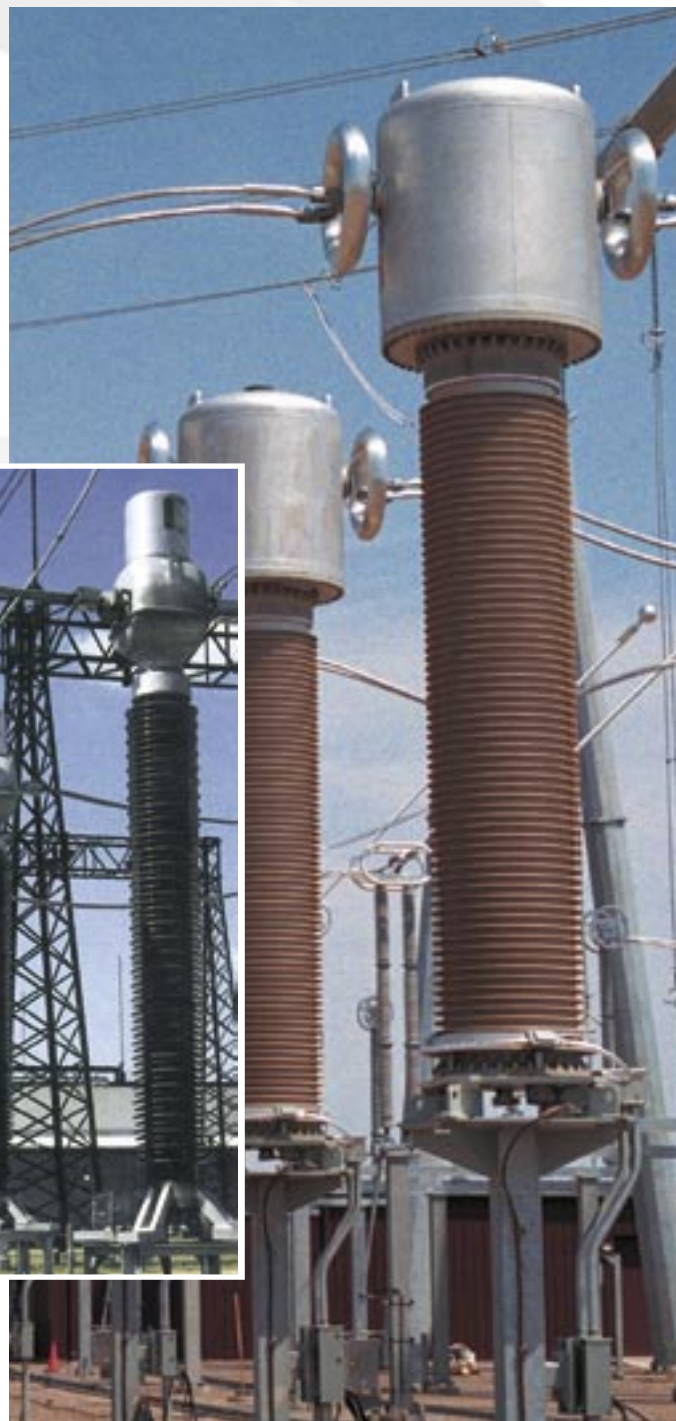
Трансформатор тока на напряжение 500 кВ с эпоксидной изоляцией и крышкой из композитного материала
