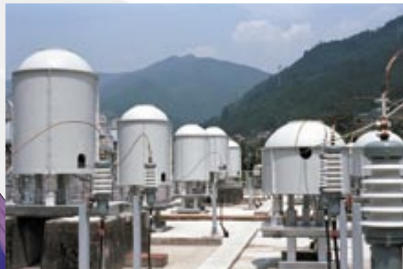
Фильтровые реакторы с шумопоглощающими экранами
