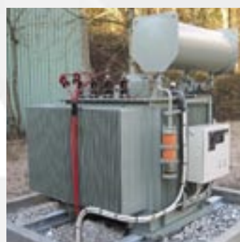
Дугогасящий реактор на напряжение 10 кВ мощностью 1000 кВАр
