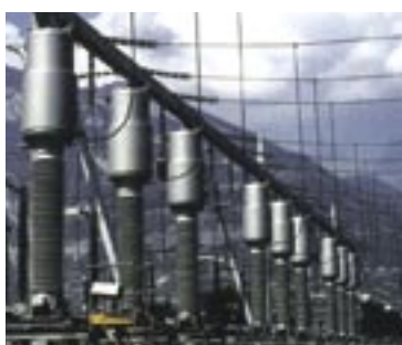
Комбинированные измерительные трансформаторы на напряжение 245 кВ с элегазовой изоляцией
