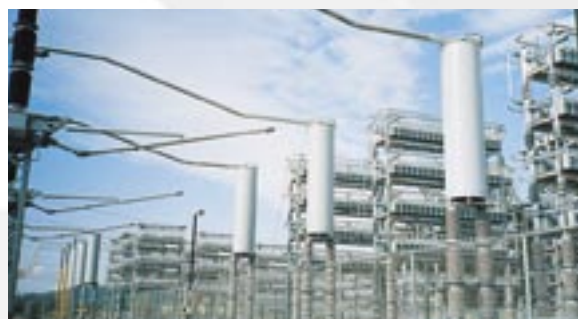
Токоограничивающие реакторы для конденсаторных батарей
