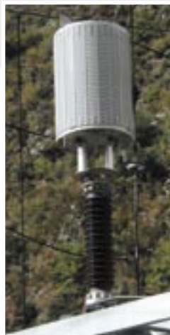
Высокочастотный заградитель, установленный на конденсаторе связи
