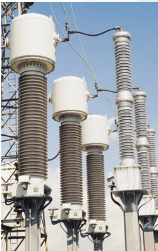
Трансформатор тока на напряжение 245 кВ с элегазовой изоляцией
