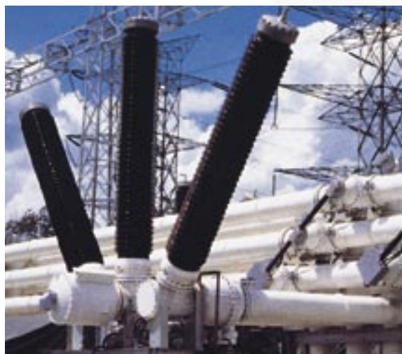
Вводы на напряжение 245 кВ с элегазовой изоляцией
