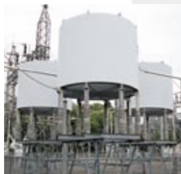
Регулировочные реакторы последовательного включения на напряжение 115 кВ
