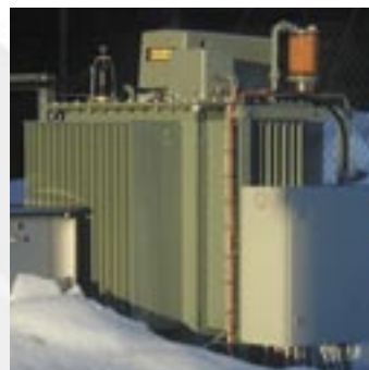
Дугогасящий реактор на напряжение 10 кВ мощностью 400 кВАр
