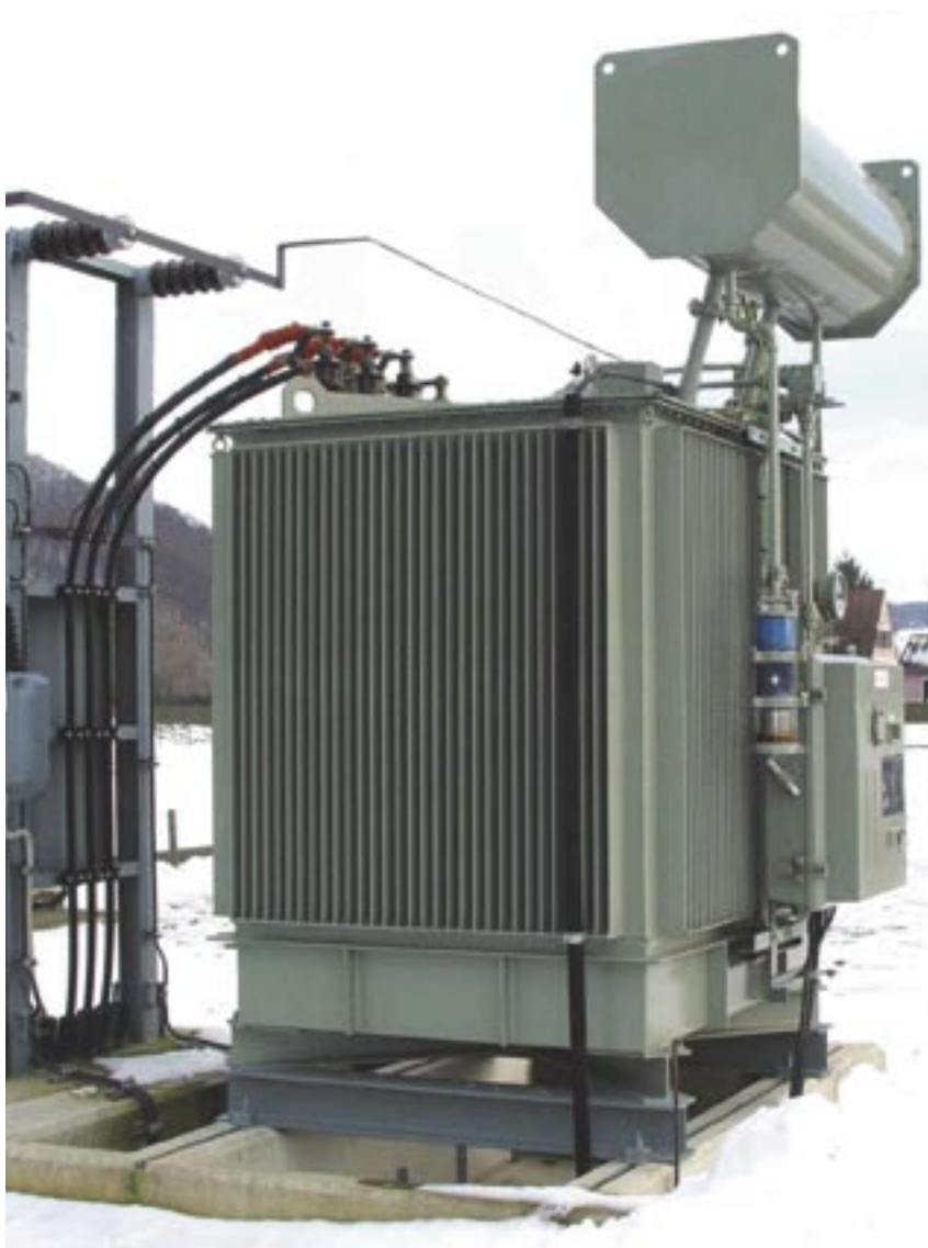
Дугогасящий реактор на напряжение 20 кВ мощностью 5000 кВАр
