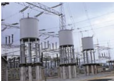
Токоограничивающие реакторы на напряжение 345 кВ
