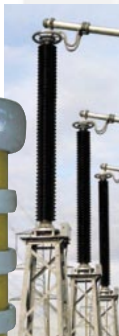
Маслонаполненный элемент делителя с фарфоровой крышкой на напряжение 420 кВ
