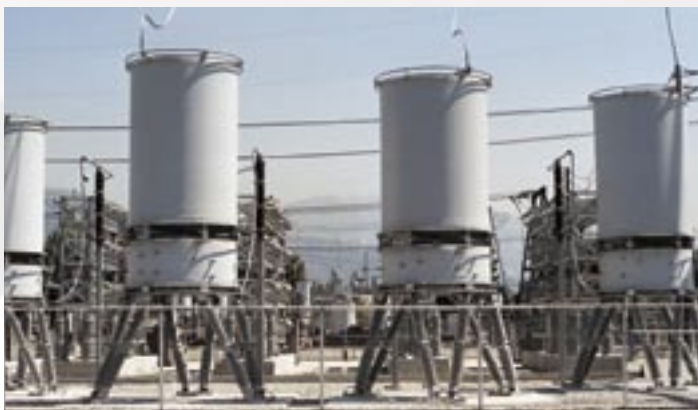
Фильтровые реакторы на номинальное напряжение 230 кВ повышенной сейсмостойкости
