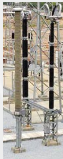
Элемент делителя с элегазовой изоляцией и композитной крышкой на напряжение 500 кВ
