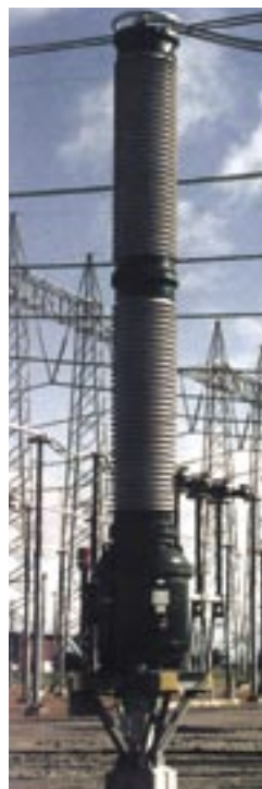
Индуктивный трансформатор напряжения на напряжение 765 кВ с элегазовой изоляцией и крышкой из композитного материала
