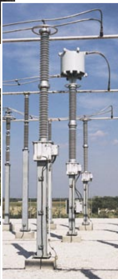
Емкостной трансформатор напряжения на напряжение 345 кВ с масляной изоляцией
