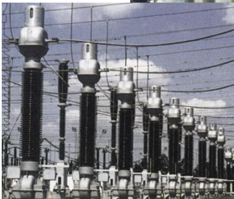
Комбинированный измерительный трансформатор на напряжение 245 кВ с масляной изоляцией
