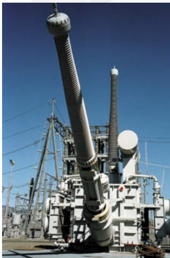
Трансформаторные вводы постоянного тока с масляной изоляцией на напряжение 500 кВ
