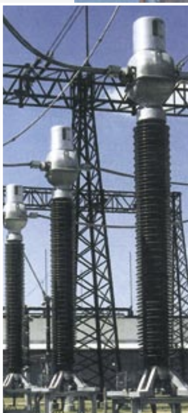
Трансформатор тока с масляной изоляцией на напряжение 245 кВ
