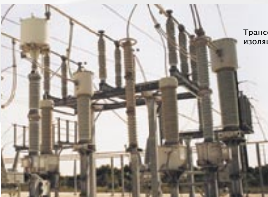
Индуктивный трансформатор напряжения с масляной изоляцией на напряжение 230 кВ
