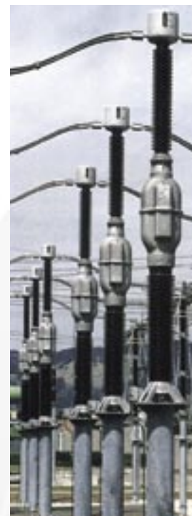
Индуктивный трансформатор напряжения на напряжение 245 кВ с масляной изоляцией
