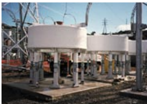
Шунтирующие реакторы на напряжение 13,8 кВ
