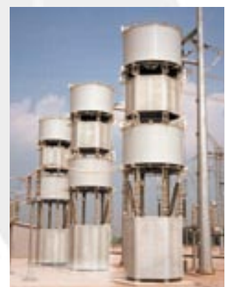
Регулировочные реакторы последовательного включения для изменения полного сопротивления линии на напряжение 138 кВ
