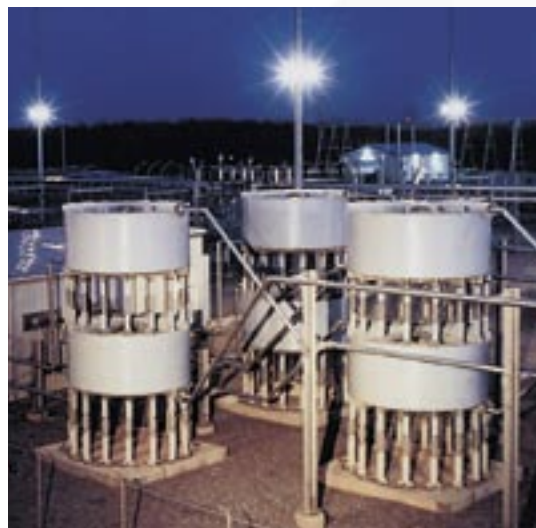
Реакторы с тиристорным управлением в схеме статической компенсации реактивной мощности
