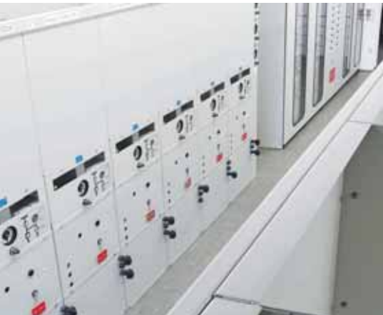
Первое КРУЭ типа 8DA10 для первичных систем распределения в BELG(сегодня E.ON Bayern AG), станция Kulmbach Mitte, Германия
